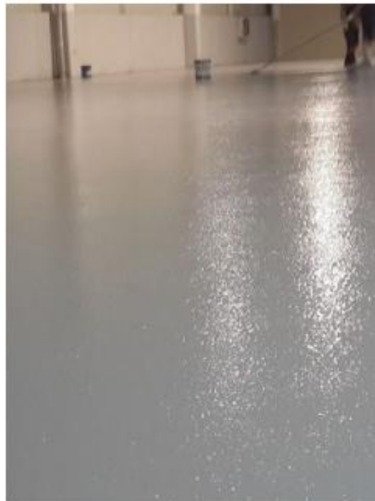
نمونه کفپوش اپوکسی و پلی یورتان با لایه سیلیس پاشی شده
